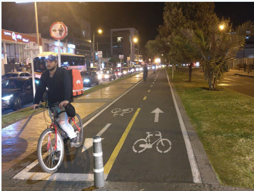
Center bike lanes (Central/ Separador)
