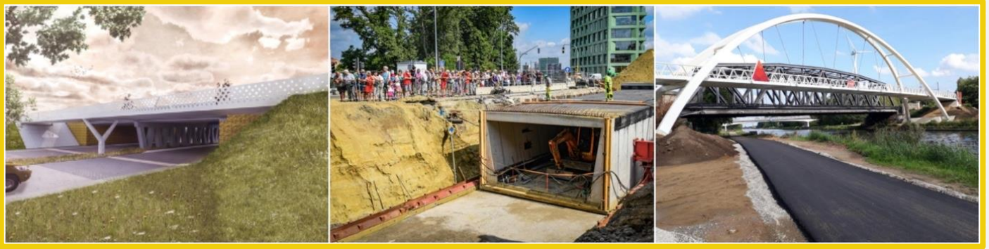
Planowanie inwestycji (1), trasa w budowie(2) i most gotowy, by powitać rowerzystów (3)
